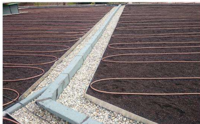
Mise en place du système d'irrigation ID DRIP
