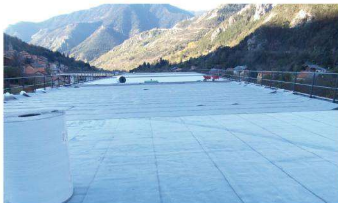
Mise en place de la nappe drainante UNIDRAIN 100
