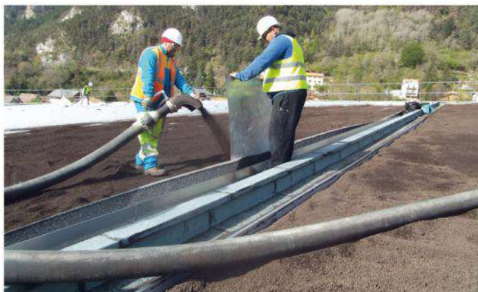
Mise en place de la couche de substrat ID FLORE Light
